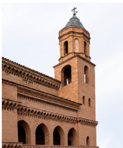
Fig. 14. Azuara. Iglesia parroquial de Nª Sª de la Piedad. Torre contrafuerte del ángulo sureste en la antigua cabecera con el adarve adyacente. Foto Jesús Criado.
