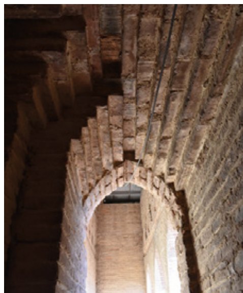
Fig. 11. Azuara. Iglesia parroquial de N a S a de la Piedad. Interior con detalle de la bóveda de la escalera intramural. Foto Jesús Criado.
