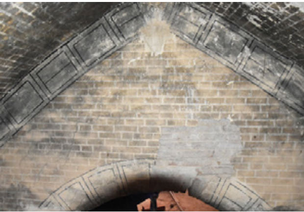
Fig. 9. Azuara. Iglesia parroquial de Nª Sª de la Piedad. Vista por el trasdós de la bóveda del muro del hastial medieval con el óculo primitivo. Foto Jesús Criado.
