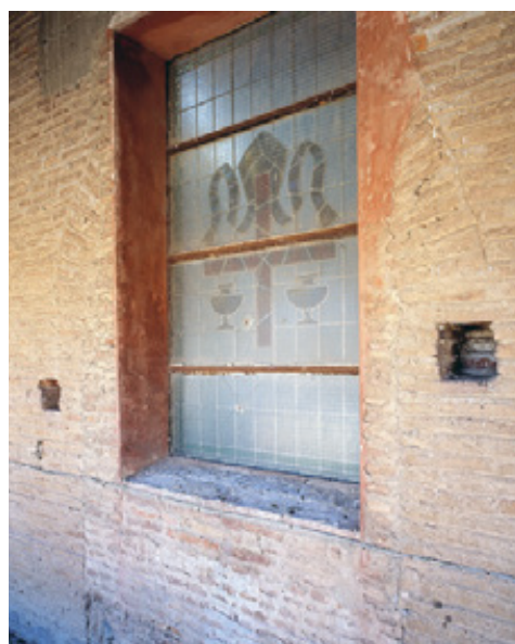
Fig. 6. Azuara. Iglesia parroquial de Nª Sª de la Piedad. Ventana ojival original de uno de los tramos de la nave visto desde el adarve norte, modificado para abrir una ventana barroca. Foto Antonio Ceruelo.
